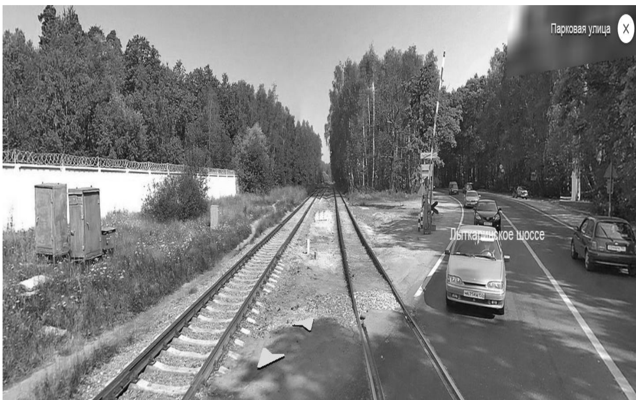
Рисунок 2 Железнодорожный переезд при въезде/выезде в /из г. Лыткарино
